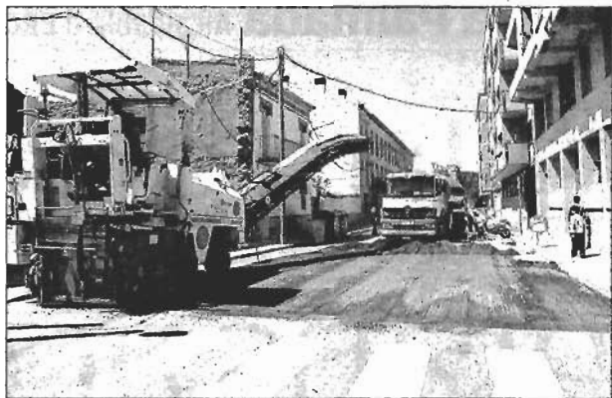
Les obres al carrer Ausiàs March ■ J.N.
