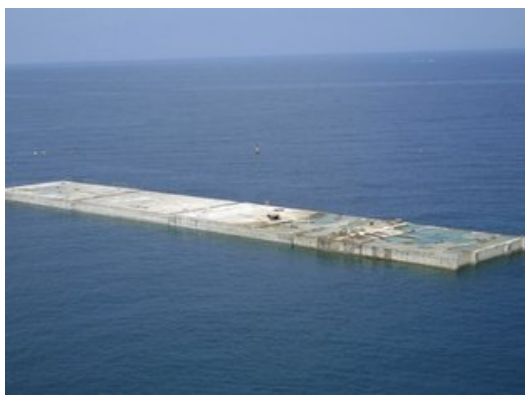
El nou dic de recer que s'ha construït davant del port de Llançà estarà acabat al juliol. Foto: EL PUNT.
