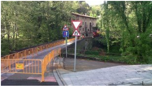
El pont de Sant Roc, asfaltat de nou.
