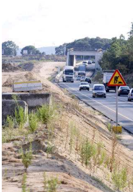
Les obres aturades entre Sils i Caldes, en una imatge d'arxiu. marc martí
