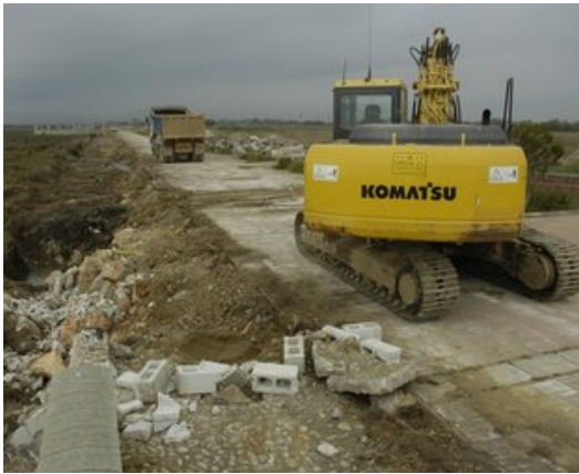
Imatge de les obres que l'Estat executa a la Pletera.
