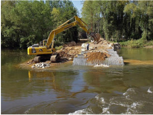
Les obres, ahir, a la passera entre Bescanó i Sant Gregori.<br/>
