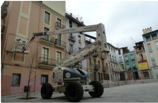
Una vista dels primers treballs de pintat de façanes iniciat a la plaça Campdenmàs. Foto: J.C.
