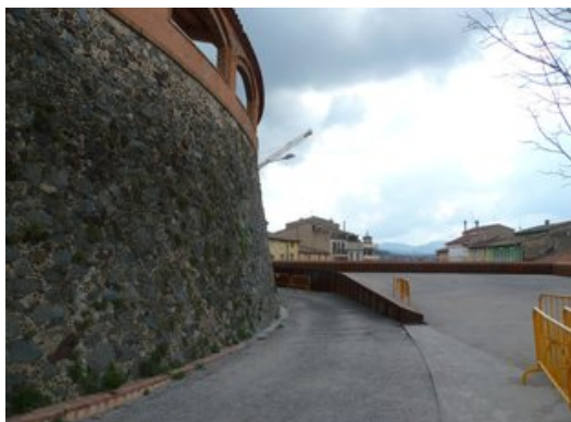
El vial d'accés als garatges de les cases que hi ha a les noves places del Torín, a punt de completar-se. Foto: J.C.
