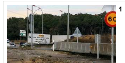
El tram entre Caldes i Sils és un dels que ha quedat amb les obres a mig fer de l'N-II. Foto: MANEL LLADÓ.
