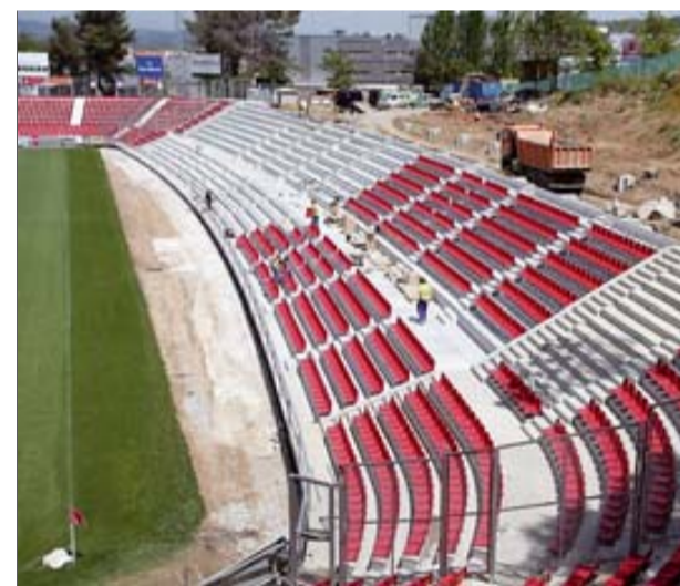
L'estadi de Montilivi, amb les darreres obres de millora que s'hi han fet ■ LLUÍS SERRAT
