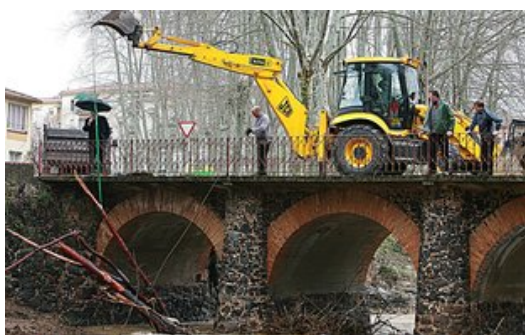
Una excavadora treballant al pont de les Mores d'Olot. Foto: M.LL..
