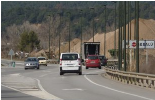
El trencant, en servei des del juliol de 2007, en una imatge de la setmana passada. Foto: R. E.
