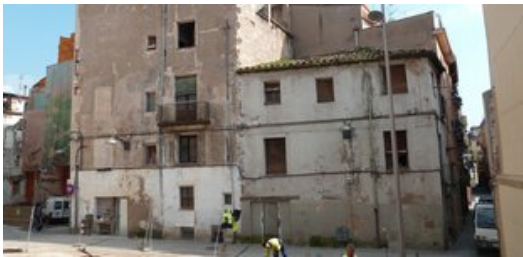
Una vista de l'edifici que ara es rehabilitarà per evitar riscos als vianants. Foto: J.C.
