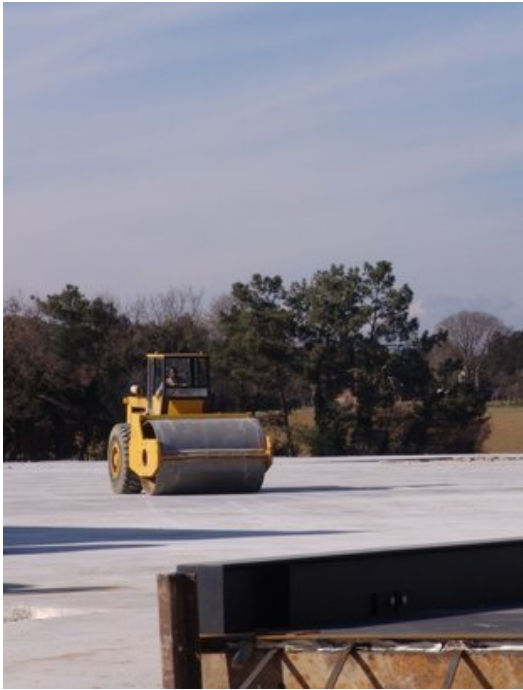
Una màquina treballa en les obres d'asfaltament on s'ubicarà la nova planta de reciclatge a Vilobí. Foto: J.M.S.
