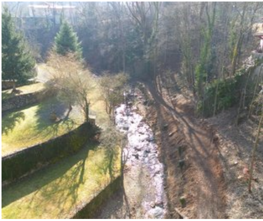
Una vista general del tram de la riera que es millora.
