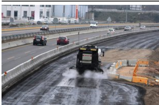
Les obres d'ampliació de l'autopista, a l'entorn de la sortida de Salt. Foto: LLUÍS SERRAT.
