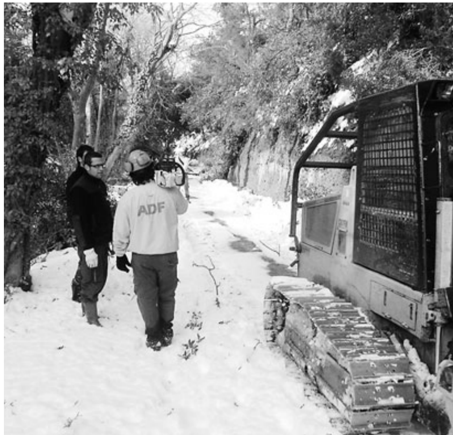
Treballs per arribar a una casa de les Gavarres, la setmana passada. / JOSEP PONJOAN
