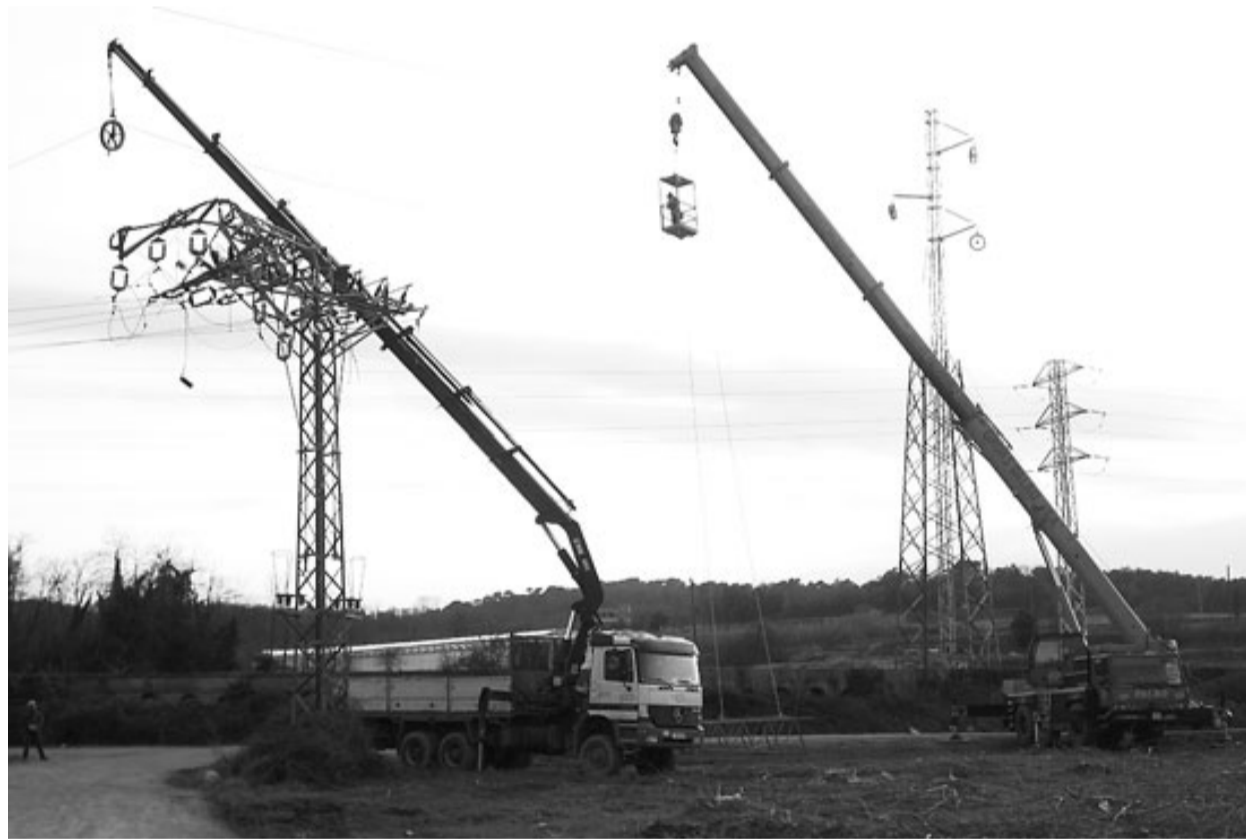
La torre trinxada per la nevada, a l'esquerra, i la nova torre a mig fer al sector entre Salt i Vilablareix. / D.V.
