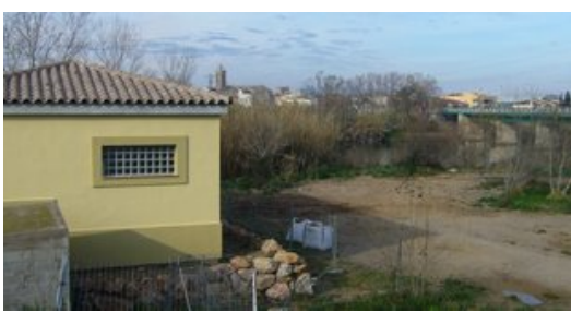
Una imatge d'una de les estacions de bombeig que s'ha construït a Sant Pere Pescador. Foto: M.V.
