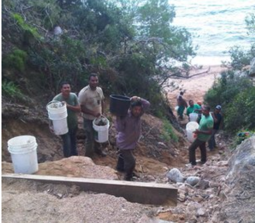
Treballadors contractats per Flinder Data, traient la sorra de la cala des Rajols, el mes passat. Foto: EL PUNT.
