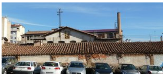
Un detall de la nau central de l'antiga fàbrica Sacrest, que es mantindrà, i la xemeneia industrial. Foto: J.C.
