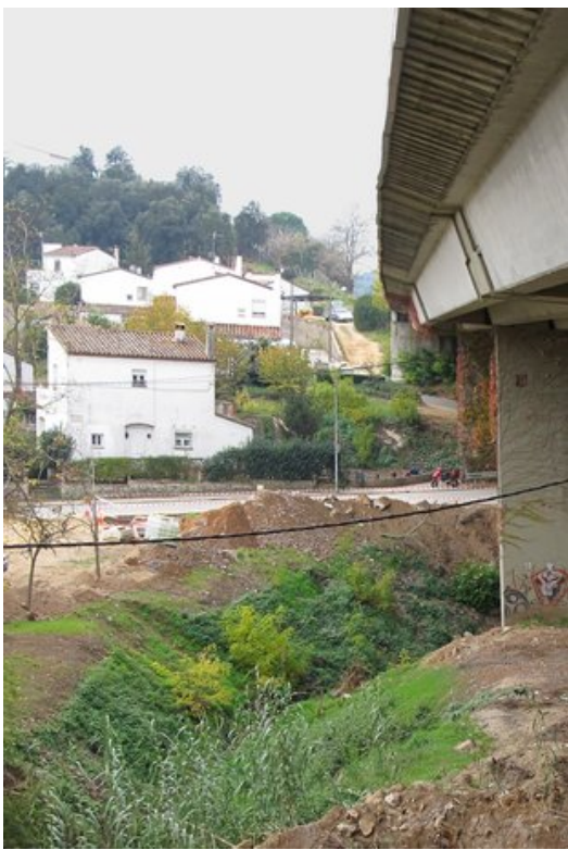
Les cases velles que s'han de derruir s'ón a escassos metres de l'AP-7. Foto: J.N.
