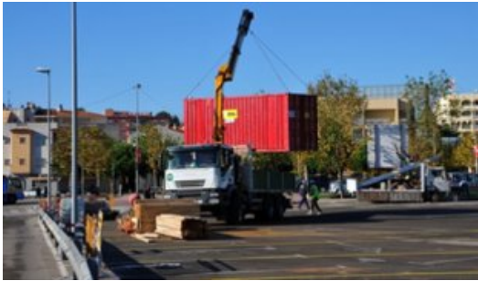
Les obres de la piscina de Lloret
