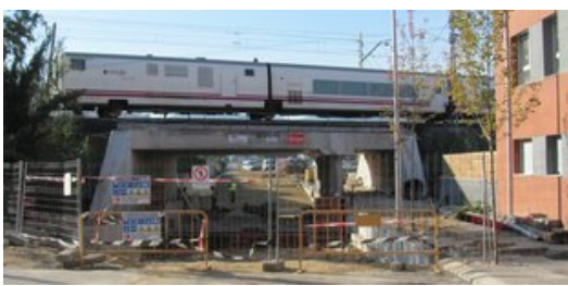
Les obres del nou pont per sota la via del tren estan ja estan molt avançades. Foto: D.V.
