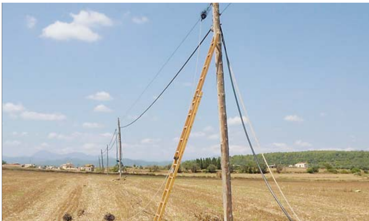
Una línia de telèfon en procés de reparació després del robatori del cable, a Cistella ■ O. PINILLA
