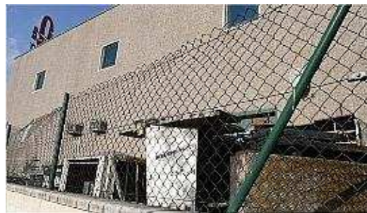
L'empresa de Vidreres que els Mossos van inspeccionar ahir. carles colomer
