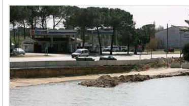
Les obres de l'N-II aturades a Caldes. Foto: MANEL LLADÓ.
