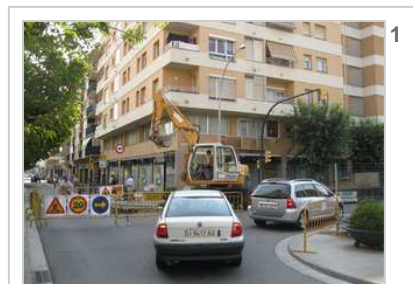
El carrer Major tallat al trànsit per la construcció d'un pou de comunicació de la xarxa de clavegueram. Foto: J.N.
