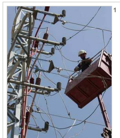
Un operari arreglant una torre elèctrica afectada per la nevada.
