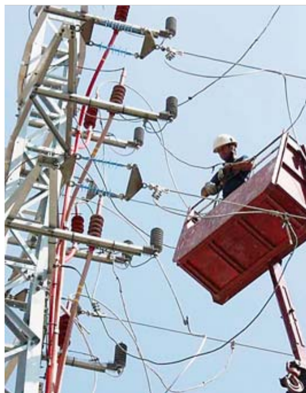
Un operari arreglant una torre elèctrica afectada per la nevada. ■ ACN
