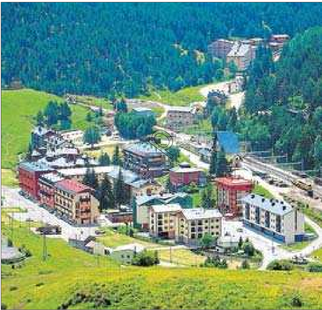
Imatge actual del barri de l'estació de la Molina
