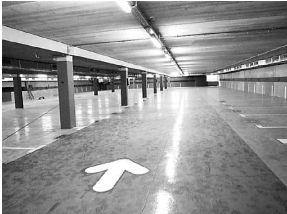
Una imatge de l'estat de l'aparcament nou de la plaça de Catalunya.
