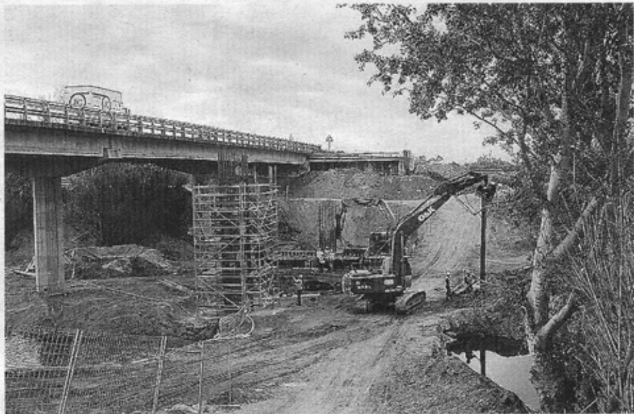
La fonamentació del pont nou ja està molt avançada. / ROBERT CARMONA
