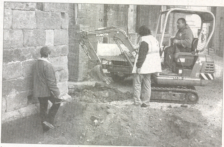
Les excavacions van començar la setmana passada
