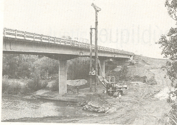
Una màquina fa la base dels pilars del nou pont / R.C.
