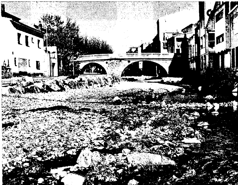
L'abocament d'àrids al Llobregat provoca embussos als ponts del casc antic
