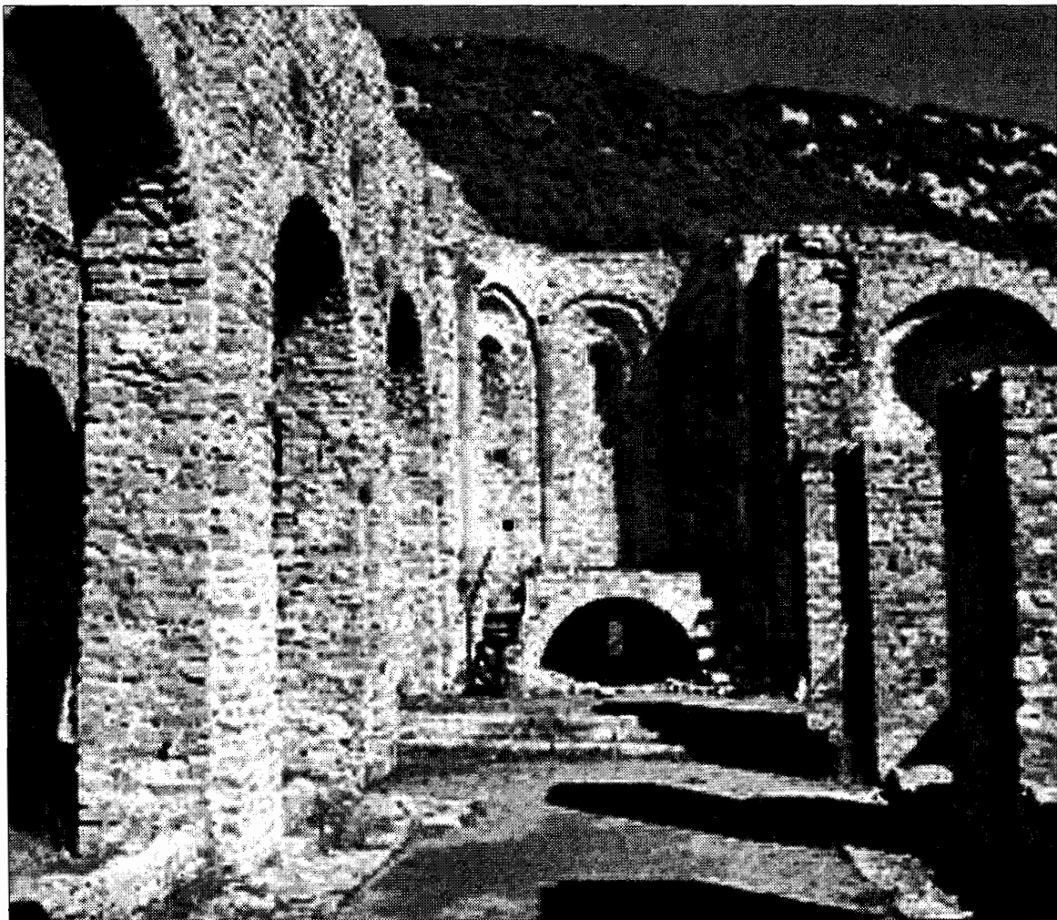
L'antic monestir d'estil romànic de Sant Llorenç de Sous, a Albanyà, rebrà un ajut per intervenir en la coberta de l'ala del claustre i consolidar les estructures descobertes en la campanya arqueològica de l'any 2004
