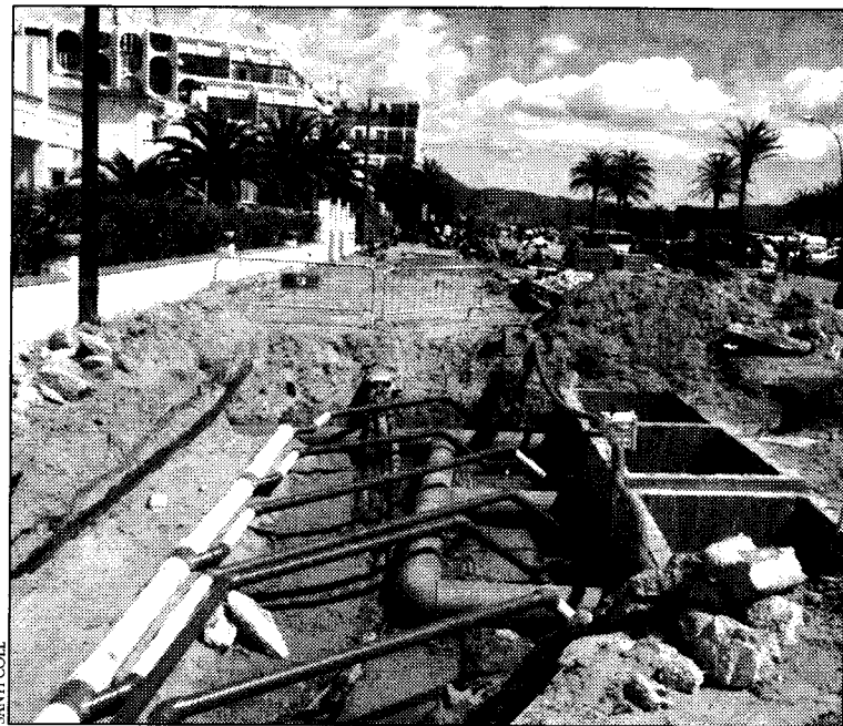
Els operaris treballen per poder acabar les obres del front marítim aquest juny
