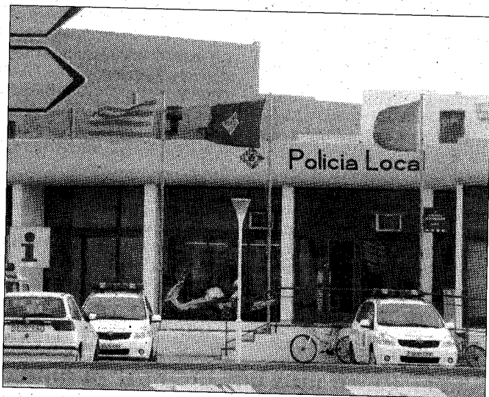
CENTRE DE SERVEIS. L'edifici de la Policia Local que s'enderrocarà.
