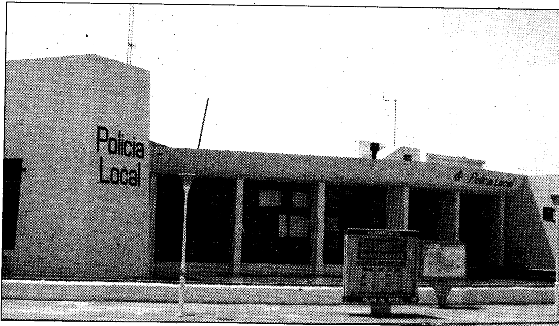
L'edifici actual de la policia local de Castelló anirà a terra i se'n construirà un de nou
