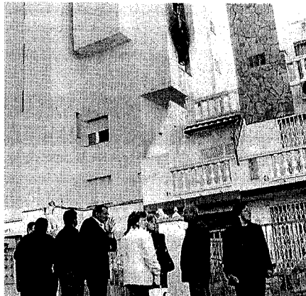
Els Mossos van inspeccionar ahir el pis on es va originar el foc i els tècnics municipals van valorar l'estructura de l'edifici. A sota, a la dreta, la paràbòlica on va caure una de les víctimes. / ROBIN TOWNSEND / ROBERT CARMONA.
