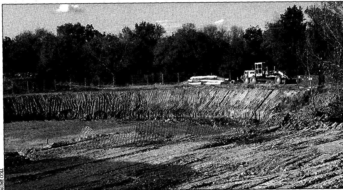
Les obres d'ampliació de la depuradora d'Empuriabrava en el seu estat actual
