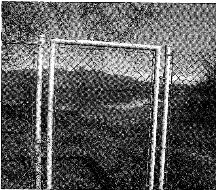
Instal·lacions actuals de la depuradora de basses de Castelló
