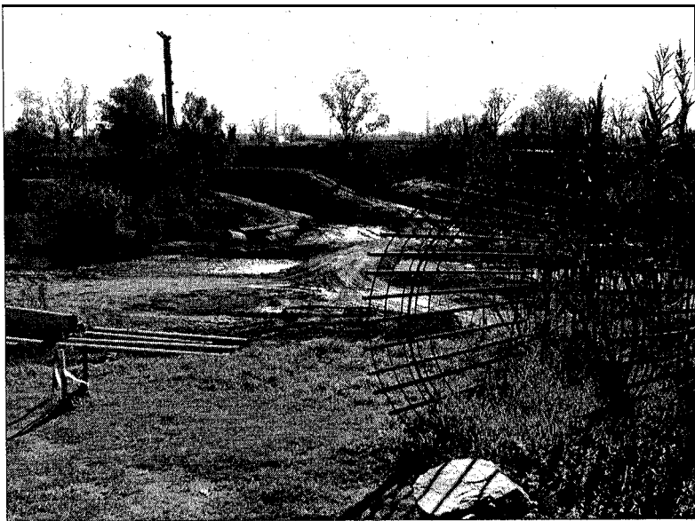
Les obres de construcció del nou pont sobre la Muga van ser adjudicades a Rubau Tarrés
