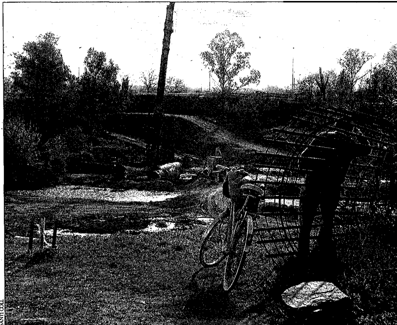
Les obres del nou pont sobre la Muga s'han iniciat amb la perforació del terra per la col·locació dels pivots de ciment armat
