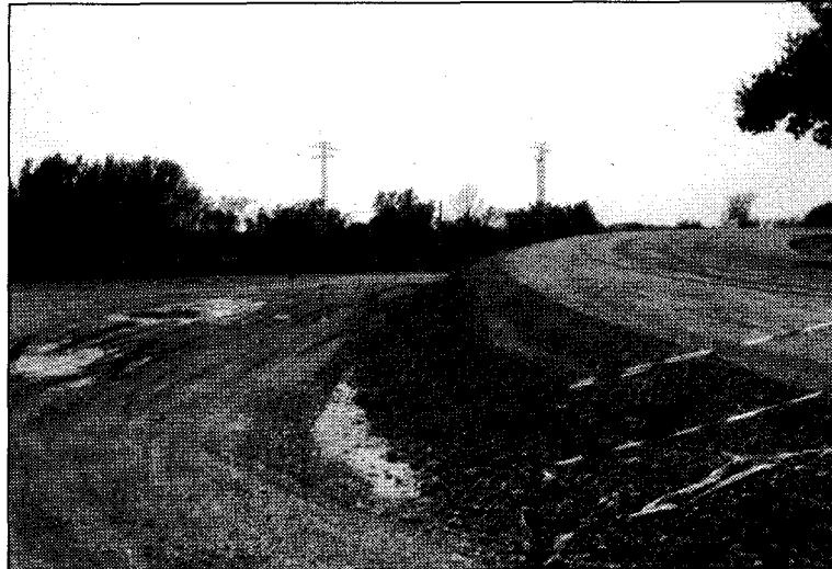
Treballs. L'operari va resultar ferit en els treballs de la carretera de Castelló.
