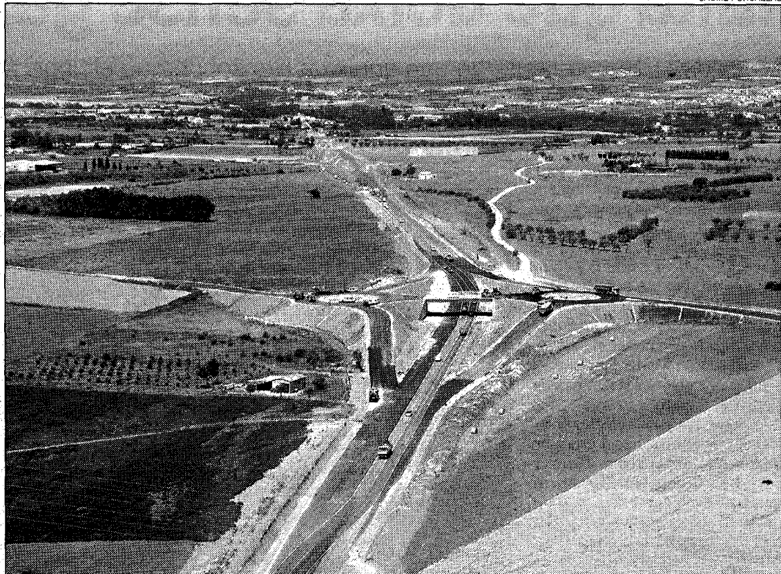
Obres C-31. Una vista aèria de fa dues setmanes de les obres a la C-31 on es veu el tram de la cruïlla amb Vilamalla
