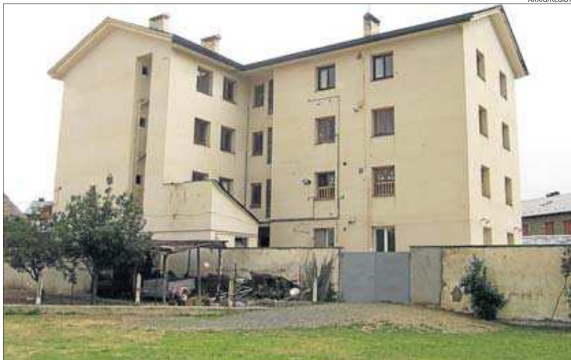
L'edifici de l'antiga caserna, que s'utilitza per a la llar d'infants
