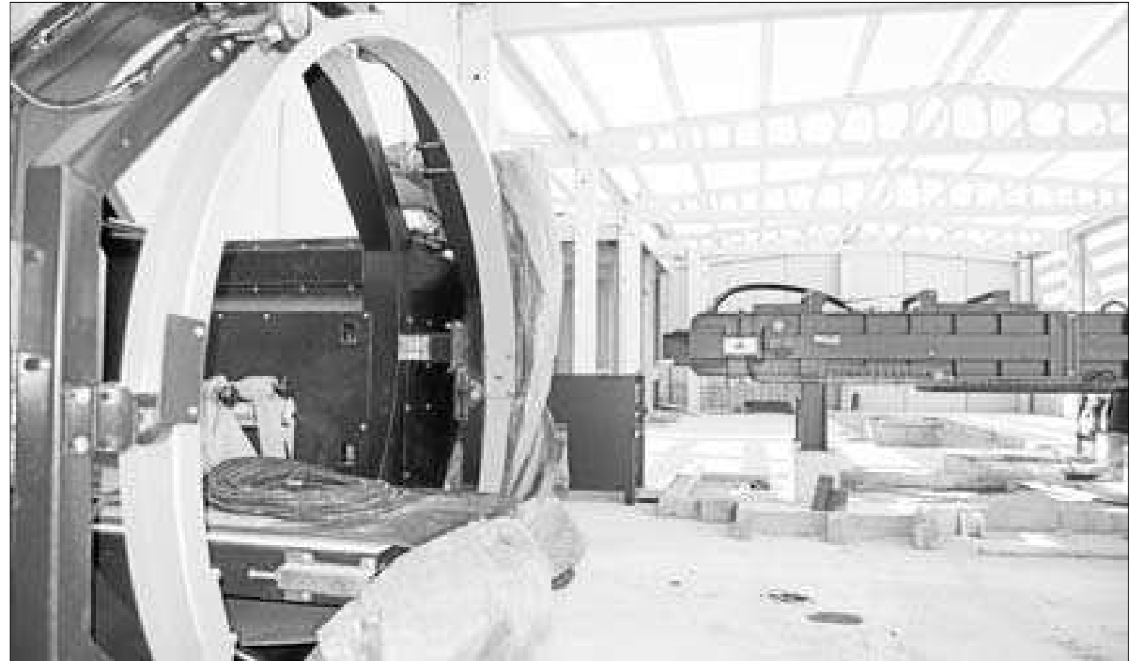
La màquina compactadora que s'està instal·lant a l'abocador comarcal de la Cerdanya, a Bellver
