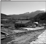
Una casa en construcció al nord de Rip, al municipi de Bellver
